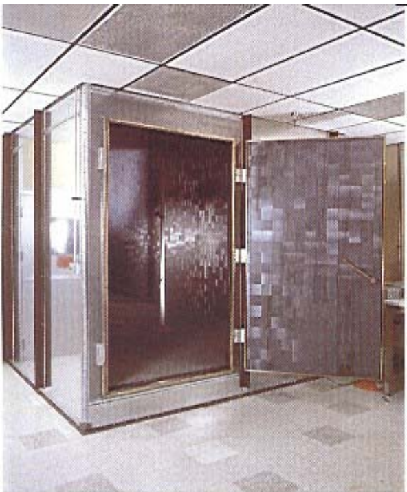
Bild: EMV Absorberraum mit Ferrit-Absorbern
