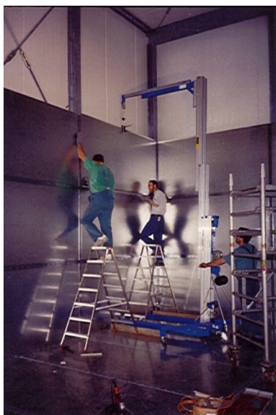
Abb.1: Abgeschirmte Kabine bei der Remontage
