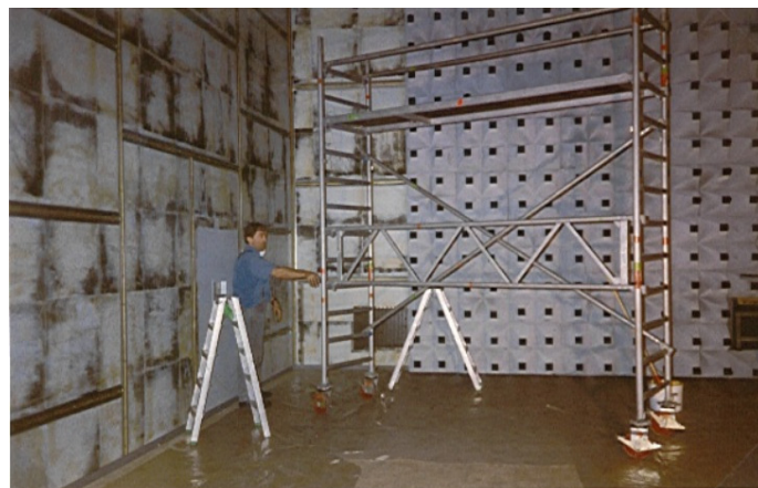
Abb.2: Demontage von festverklebten Pyramidenabsorber
